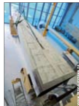
▲ Mise en place sur la coque centrale d'un tronçon de 7 m.
